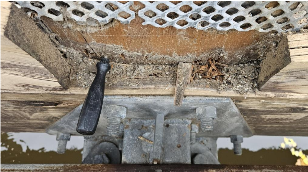
Styčnick č. 19 dolního pasu před mechanickou kontrolou
