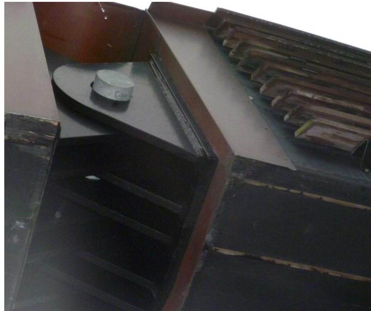
Ochrana horním oplechováním a bočním obkladem
