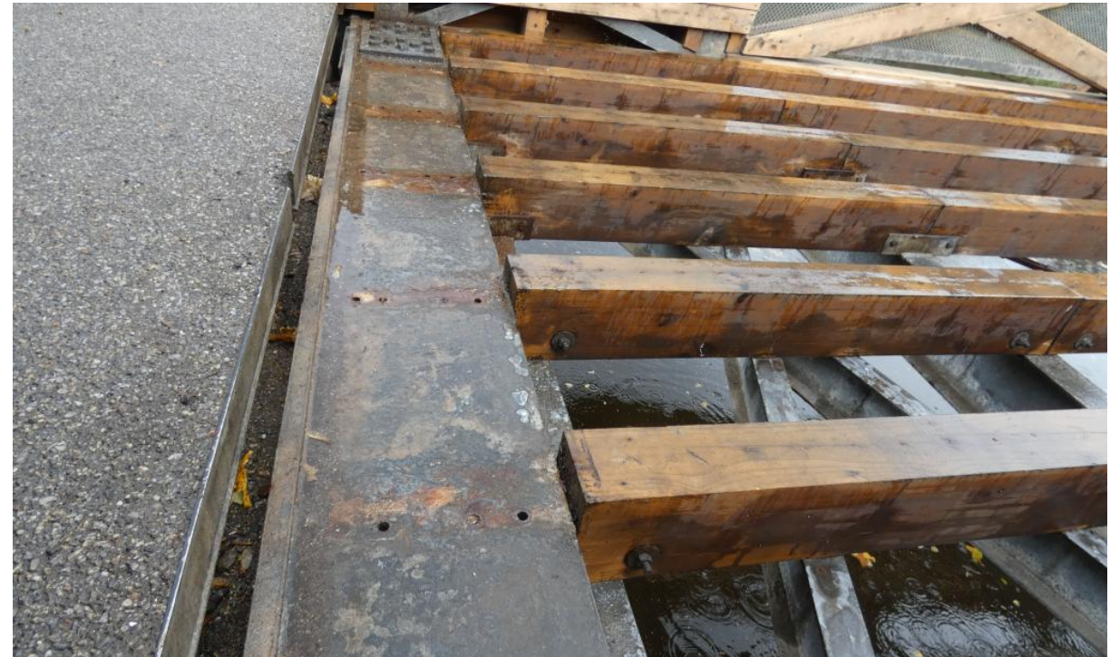
Čela podélníků uložena nadoraz k ocelovému profilu
