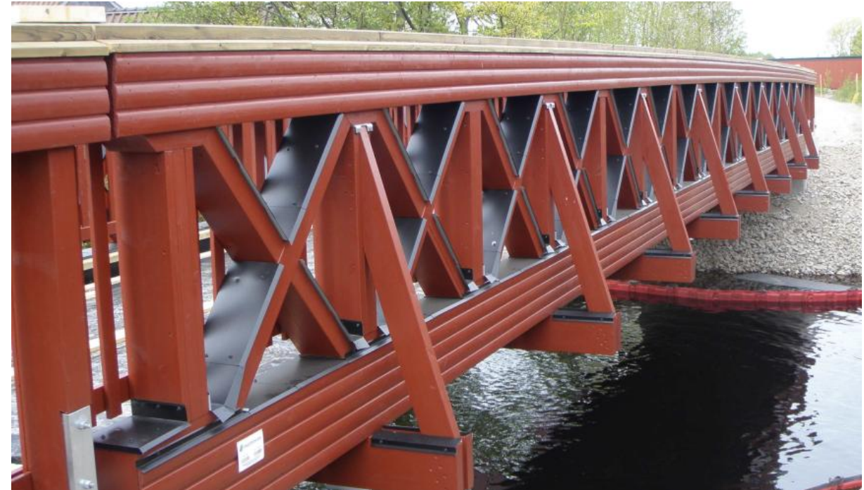
Konstrukční ochrana příhradové lávky přes vodní kanál Tofta
