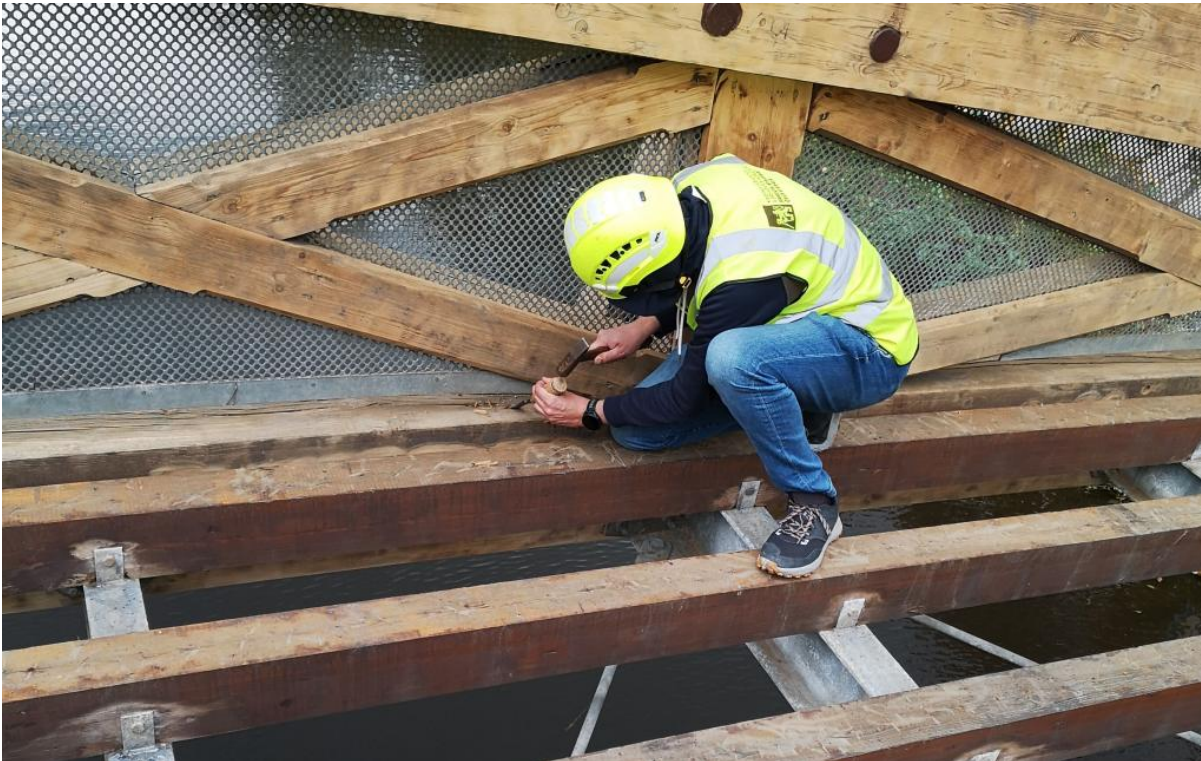
Odběr vzorků z dolního pasu příhradového vazníku
