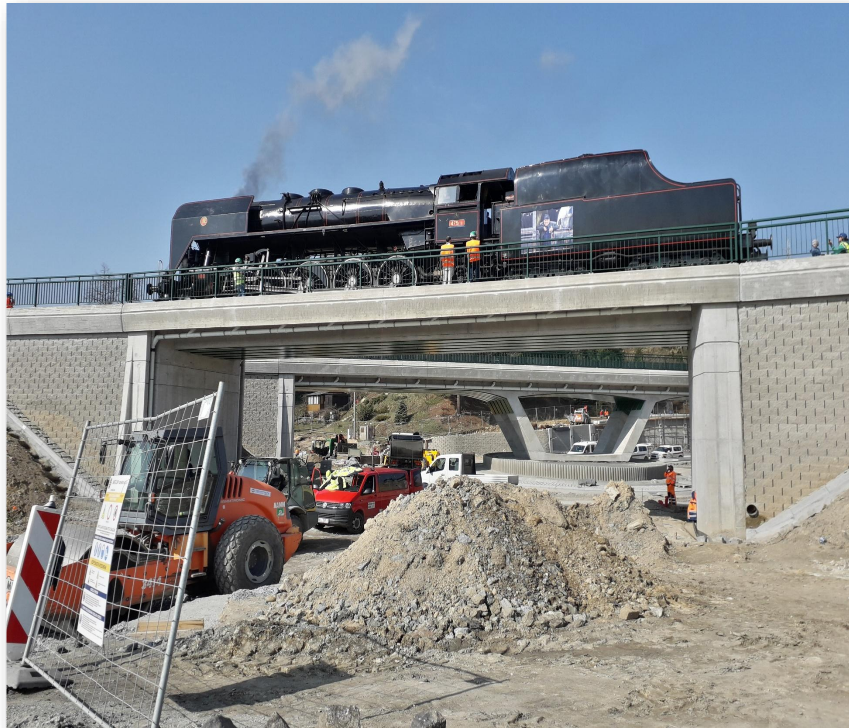
Průběh zatěžovací zkoušky železničního mostu v Plzni
