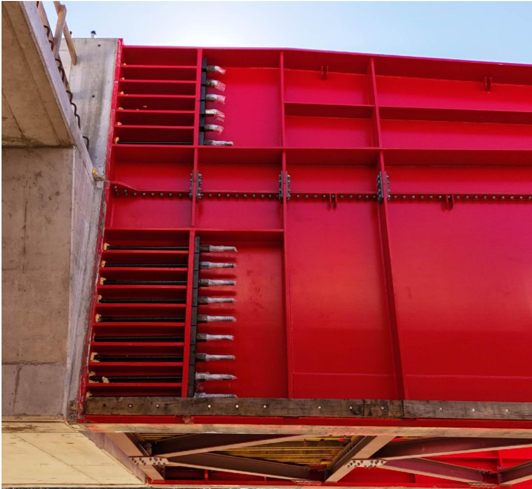
Kotvení výsuvného nosu do komory mostu pomocí předpínacích tyčí
