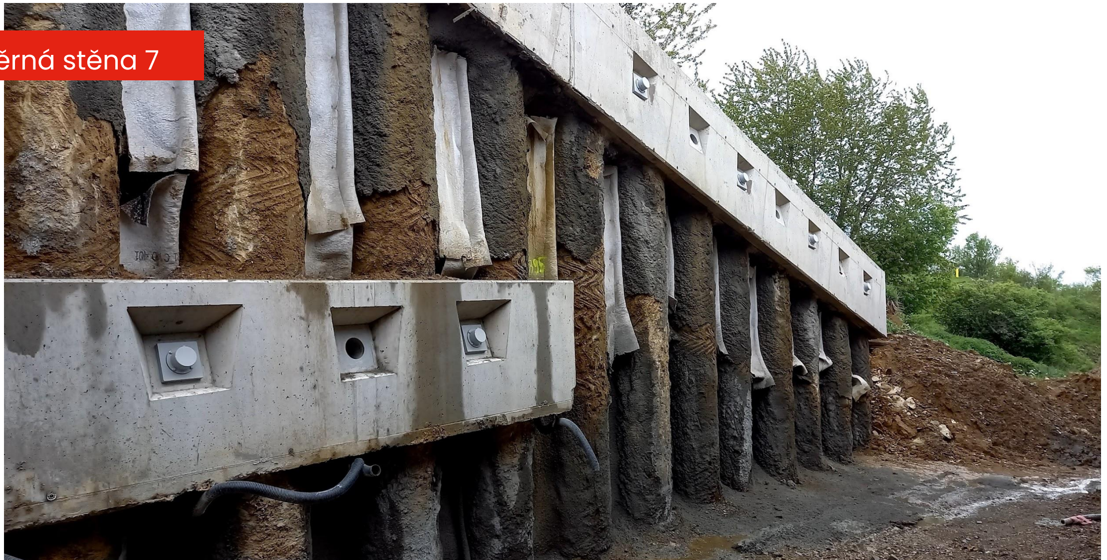
▲ Dvouetážové kotvení (květen 2023)
