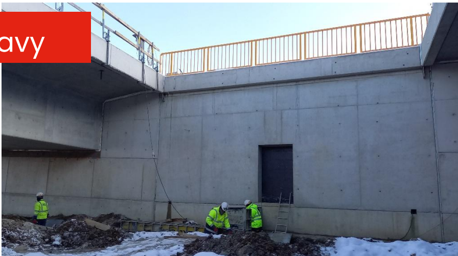
▲ Revizní komora v opěře 7 (listopad 2023)
