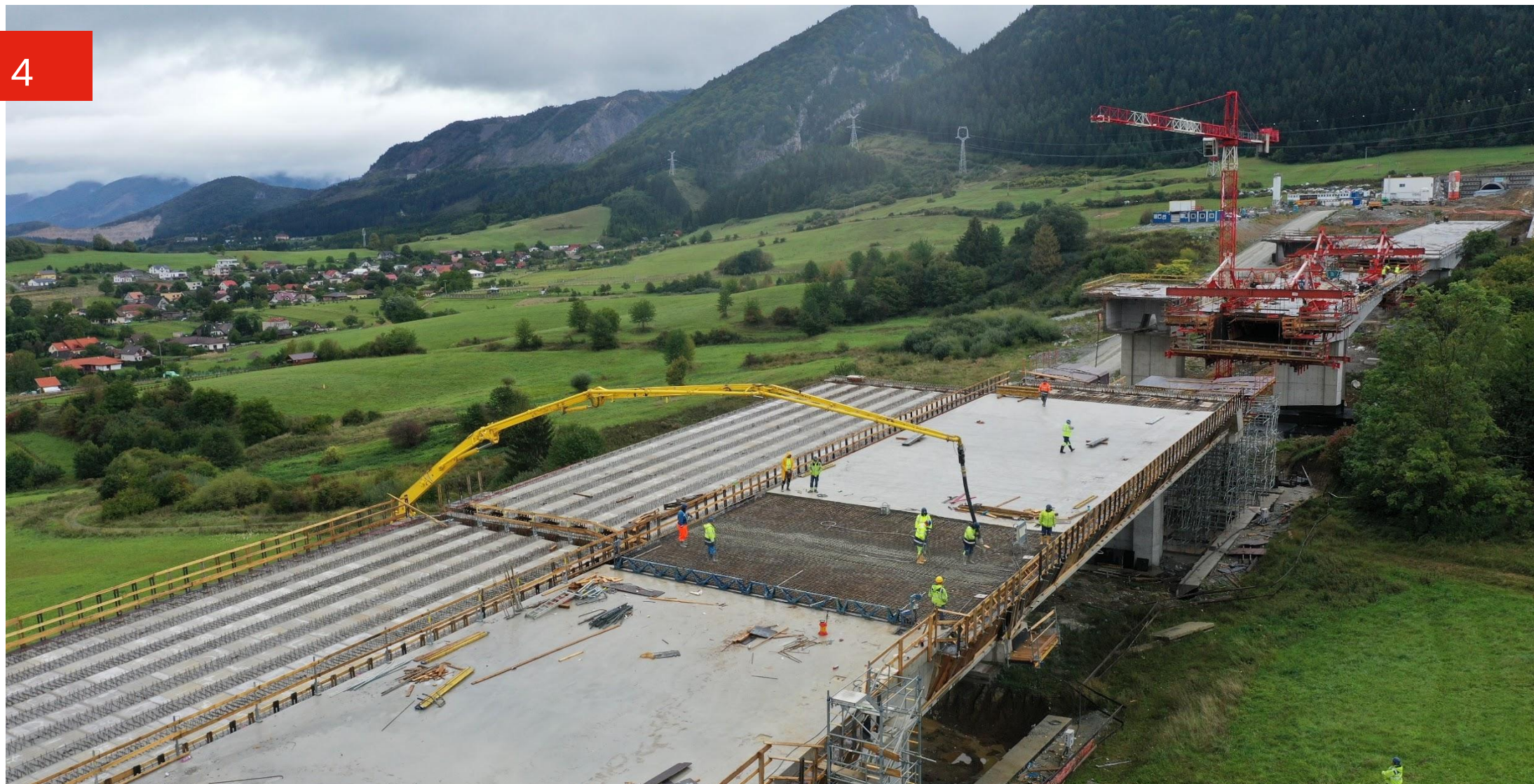
▲ Prefabrikáty, betonáž poutnickým způsobem
