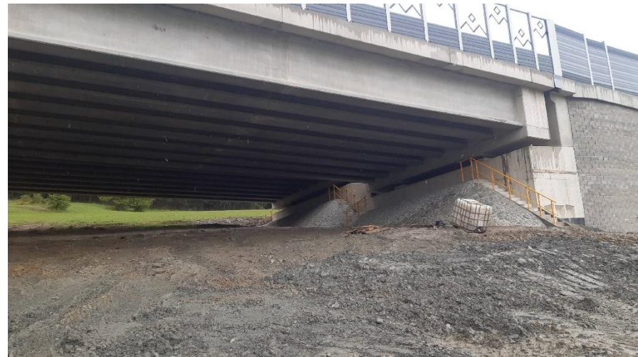
▲ Revizní schodiště (duben 2024)
