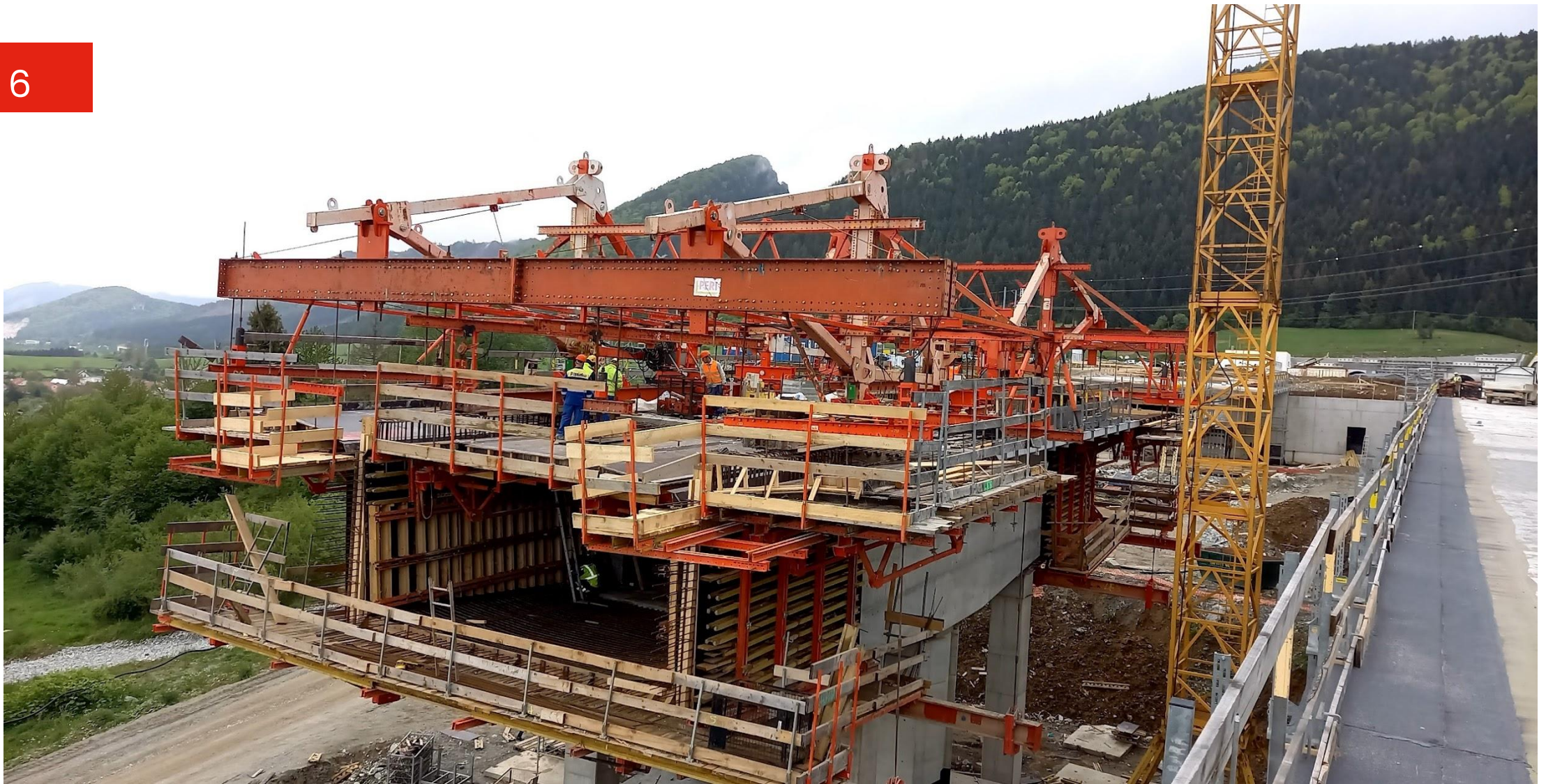
▲ LM: Betonážní vozík (květen 2023)
