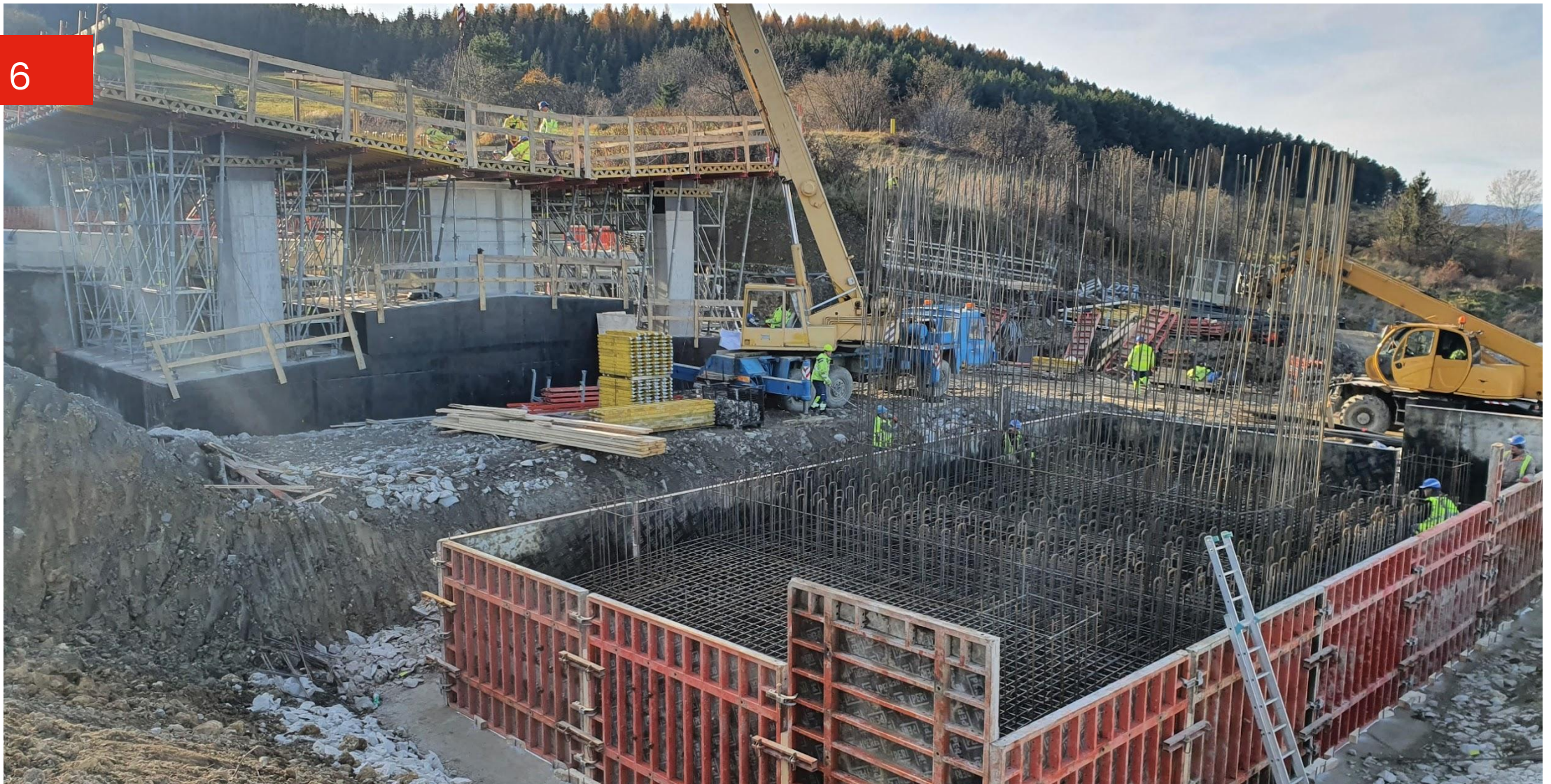
▲ PM: Základ, stabilizace zárodku, jeho bednění
