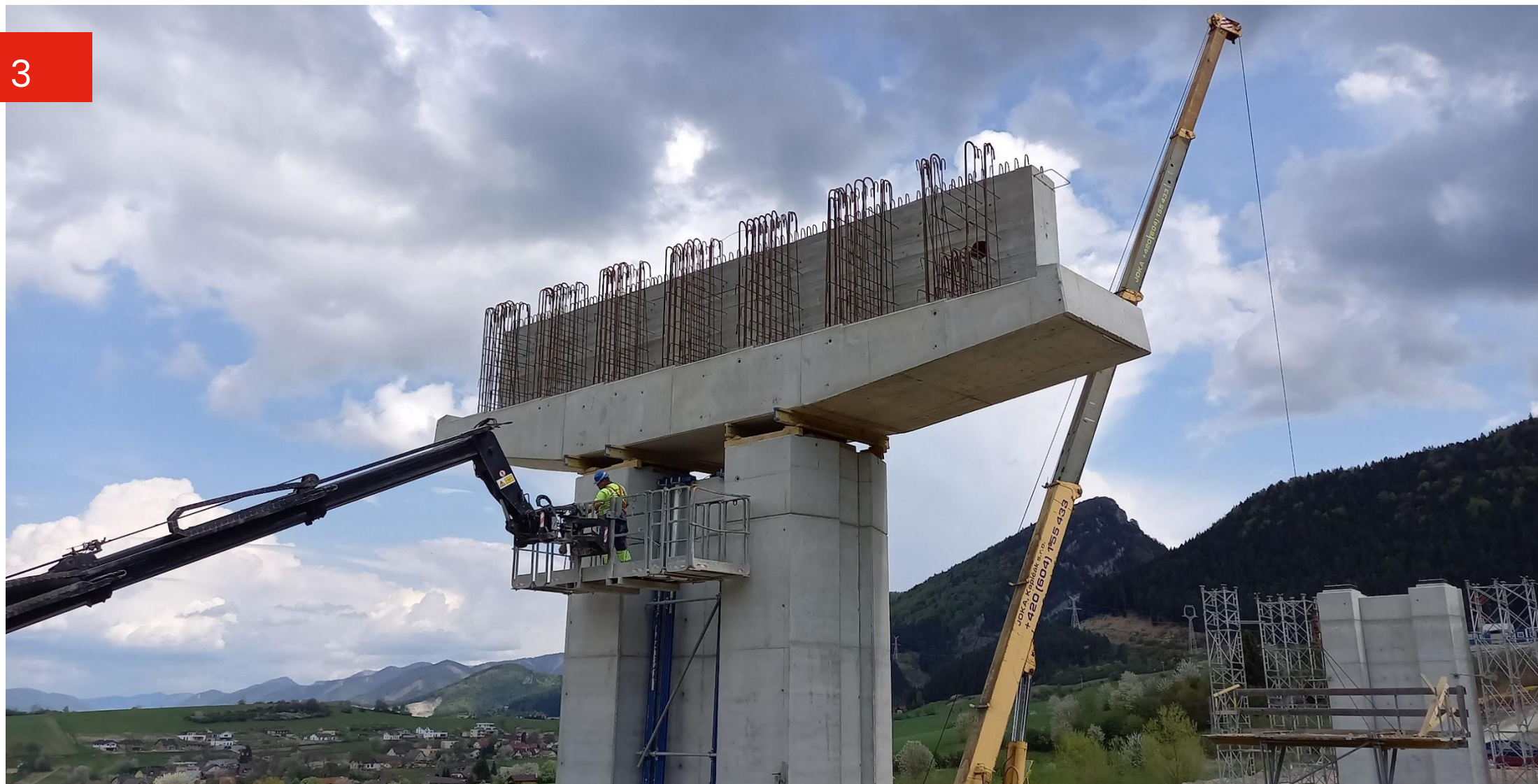
▲ Nepřímé uložení, T zárodek příčnicku
