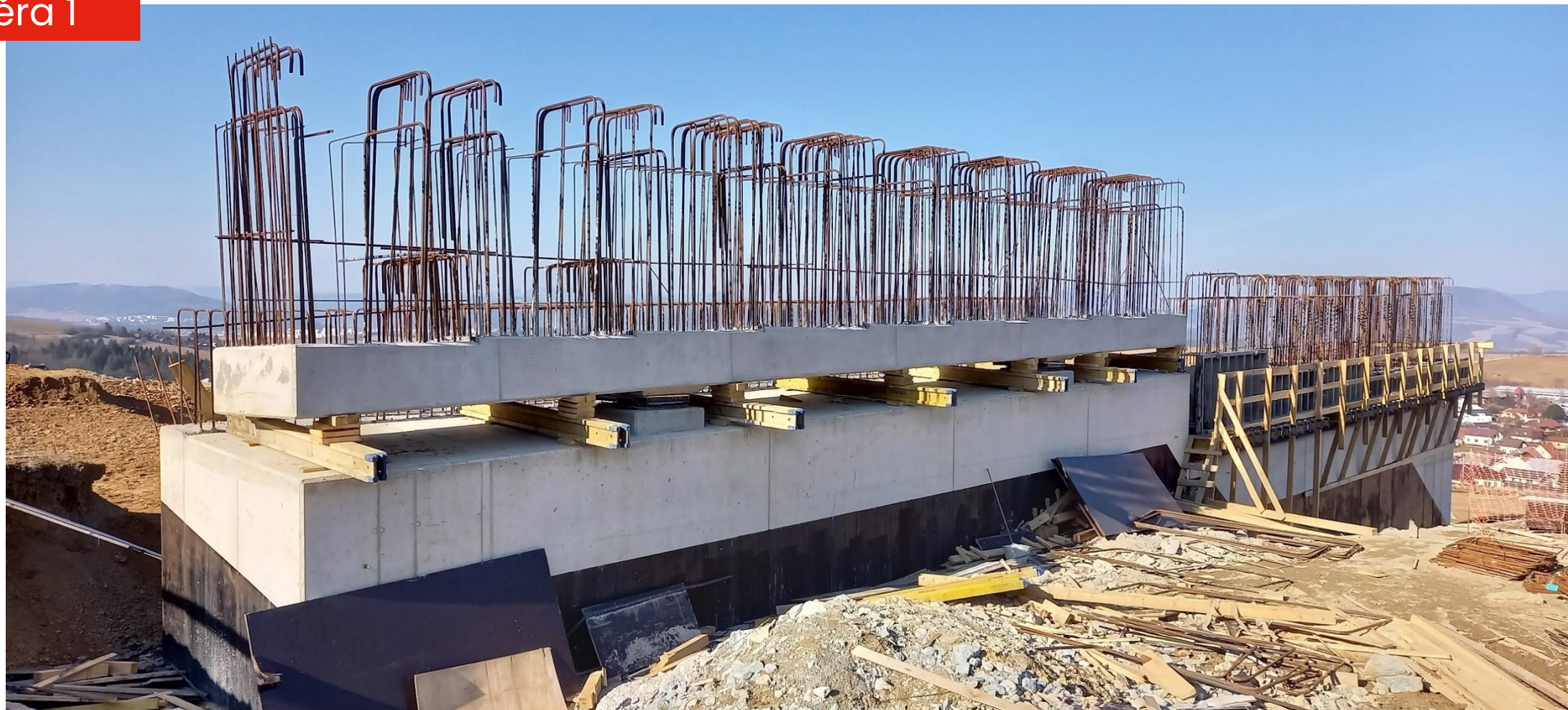
▲ Dřík opěry a zárodek koncového příčnicku
