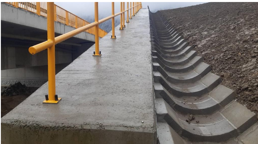
▲ Zábradlí na opěrné zdi (duben 2024)
