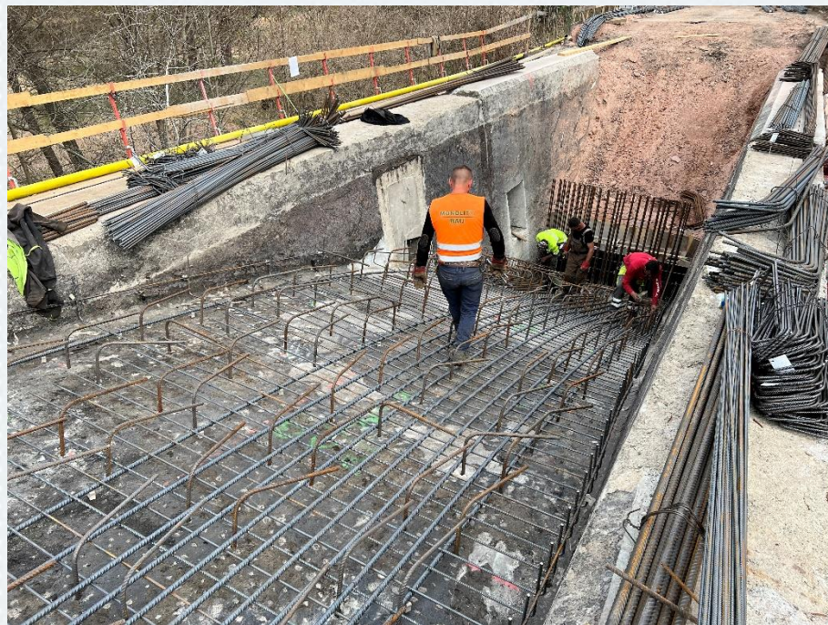
Instalace spřažení nového oblouku
