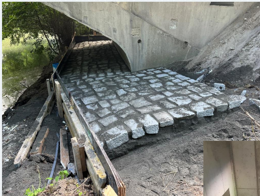
Zpevnění pod mostem
