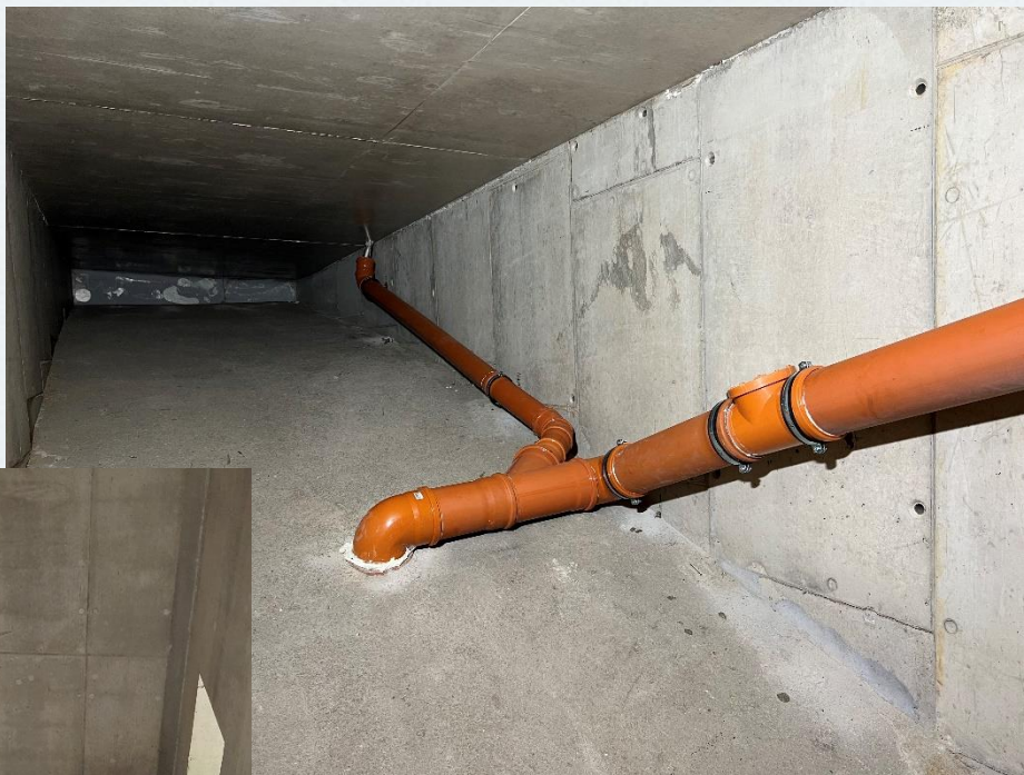
Odvodnění uvnitř mostu
