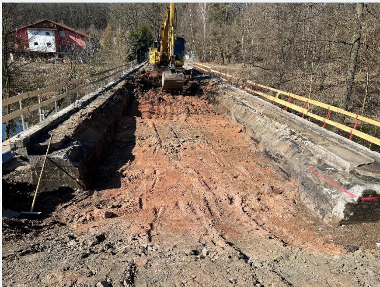
Odstranění vnitřního zásypu
