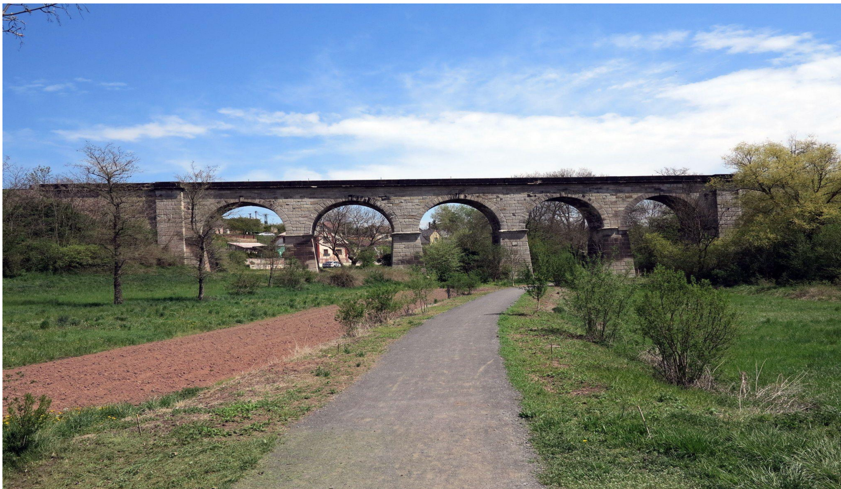
Podlešín – Slaný viadukt Podlešín
