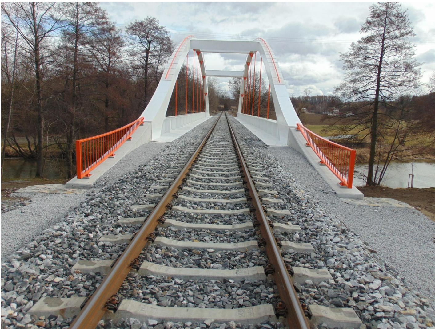
Rekonstrukce mostu v km 0,989 na trati Havlíčkův Brod – Pardubice – Rosice n/L.
