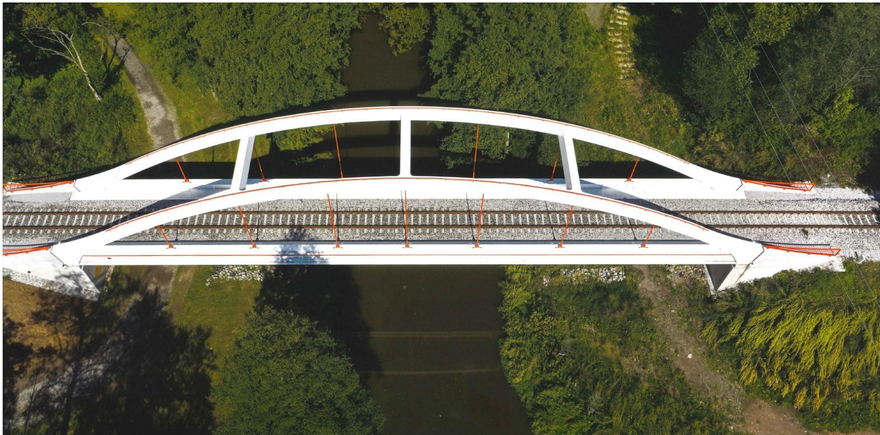
Rekonstrukce mostu v km 0,989 na trati Havlíčkův Brod – Pardubice – Rosice n/L.
