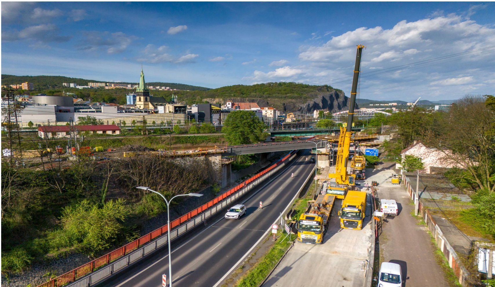
Ústí n. Labem osazení mostu
