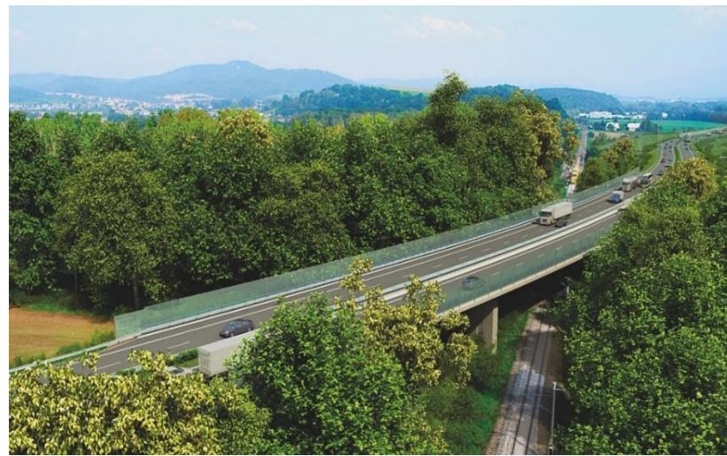
Most na cestě I/44 přes trať ČD Zábřeh-Bludov (1442 t)
