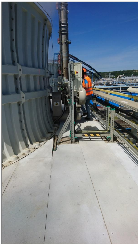
Obr.7-9 Chladicí věž – pochozí střecha/ zatížení 0,75kN/m 2
