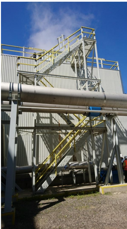
Obr.7-9 Chladicí věž – pochozí střecha/ zatížení 0,75kN/m 2
