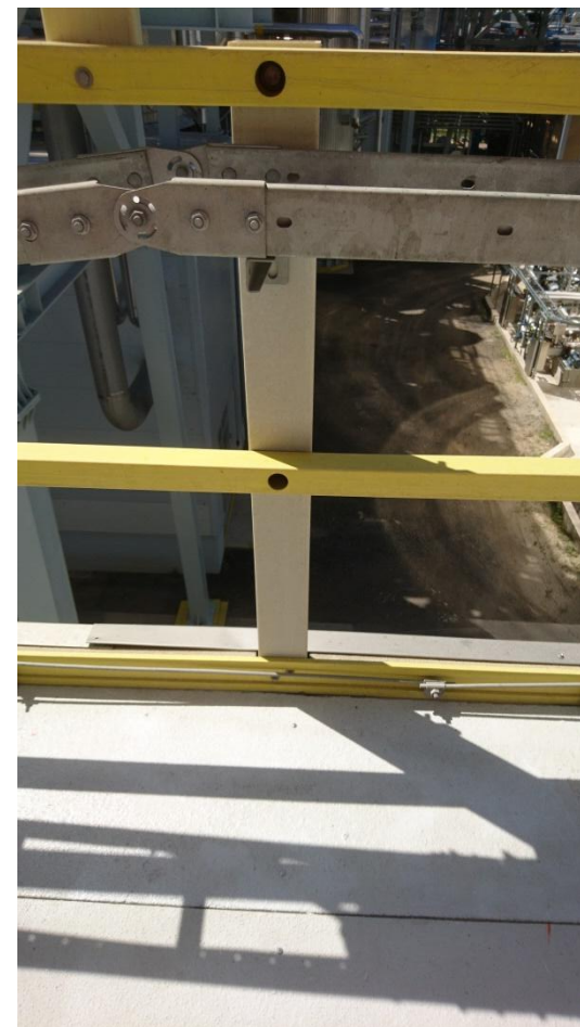
Obr.7-9 Chladicí věž – pochozí střecha/ zatížení 0,75kN/m 2
