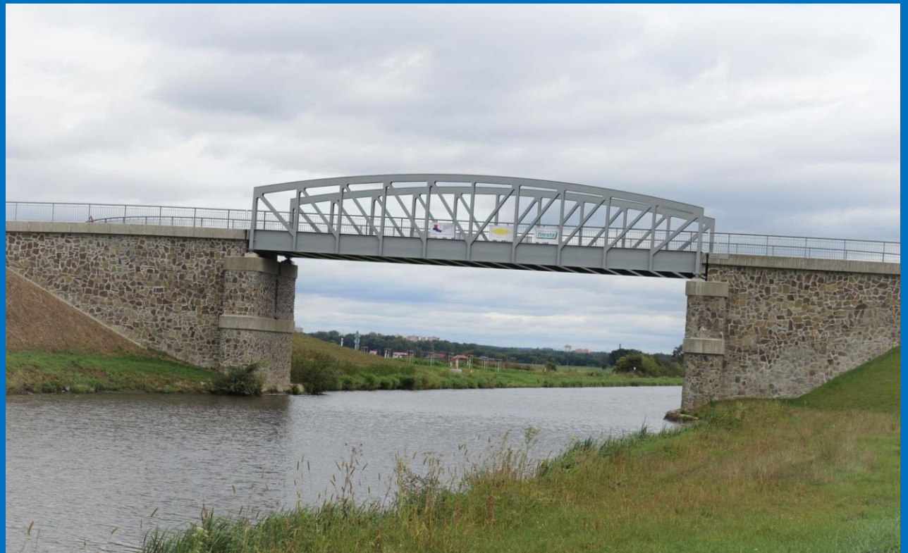
Foto po realizaci
