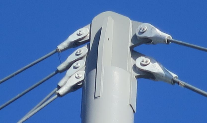
Detaily kotvení lan
