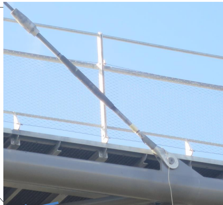
Detaily kotvení lan
