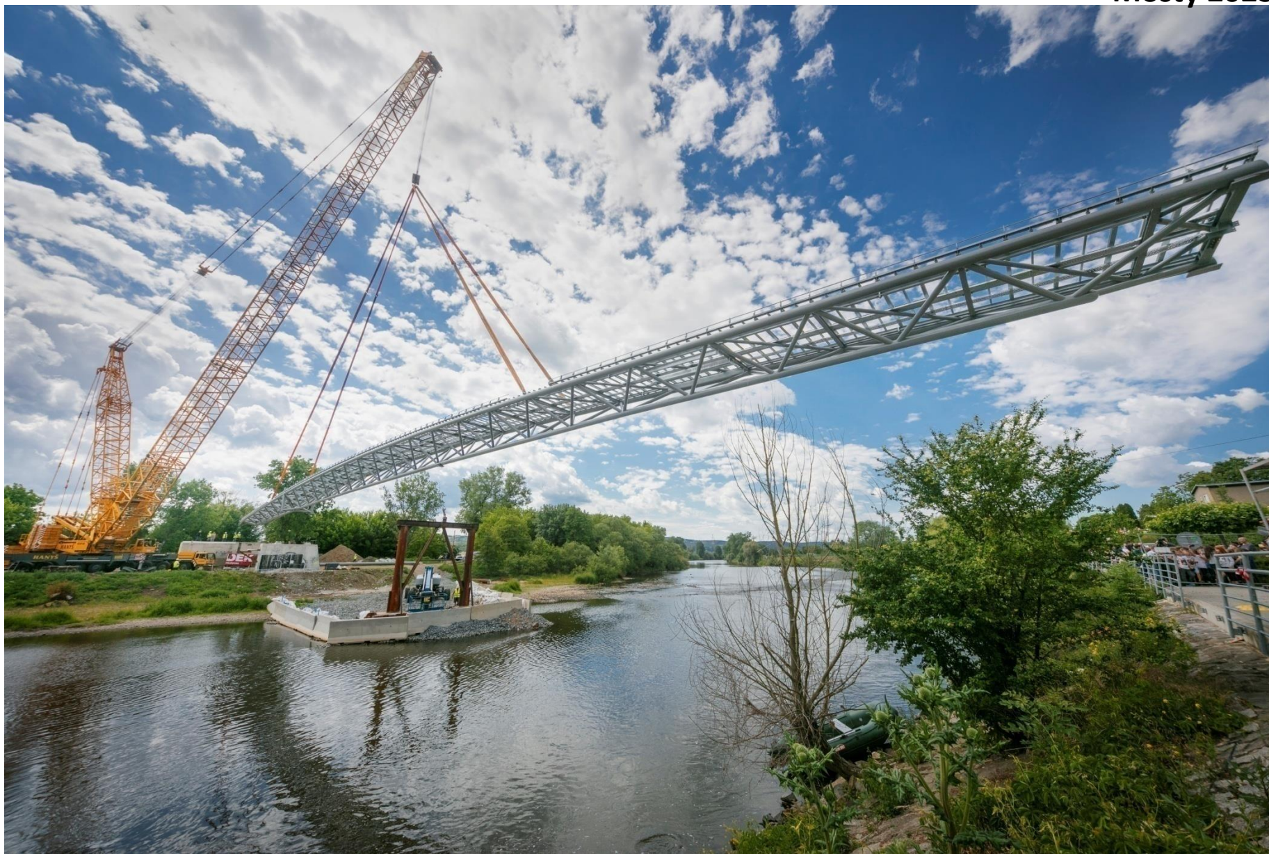
Rekonstrukce lávky v Radotíně
