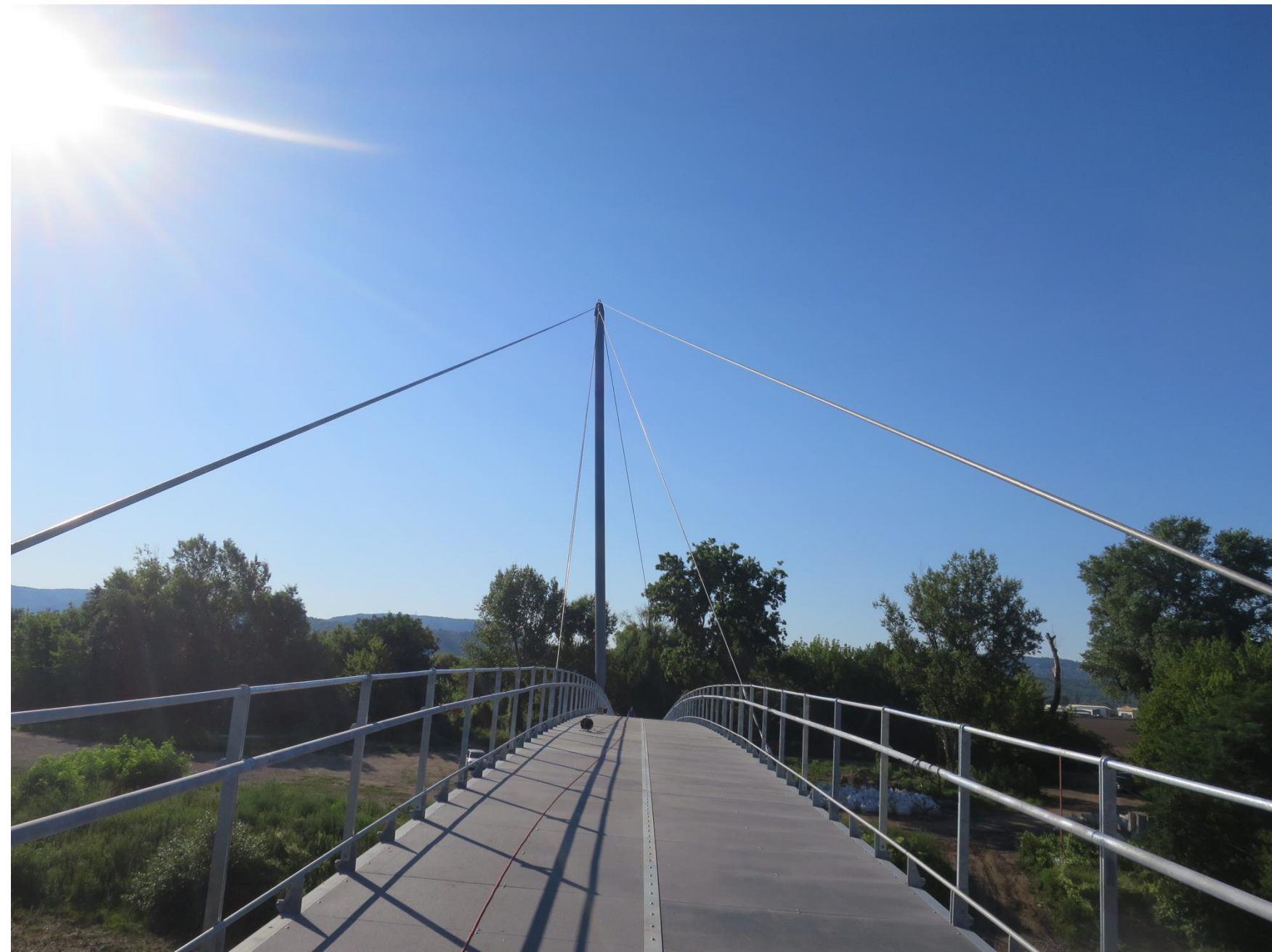
Rekonstrukce lávky v Radotíně
