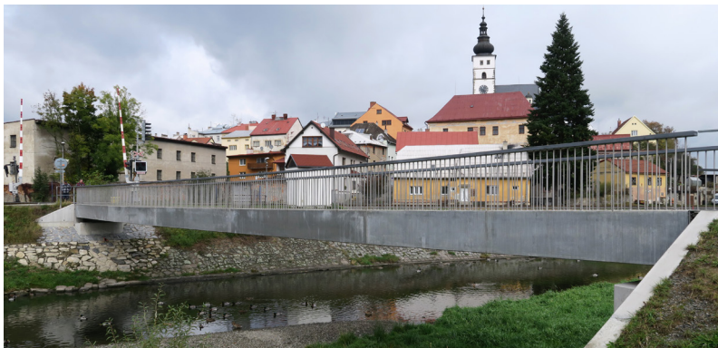
Obr. 6 Lávka z UHPC v Příboře (2019)
