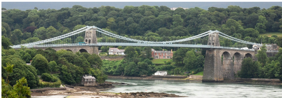
Obr. 2 Most přes úžinu Menai ve Walesu (1826)
